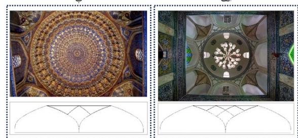
شکل ۴. کاربردی در شکنج، الف) کاربردی معمولی در شکنج: گنبد مسجد سید عزیز الله تهران ب) کاربردی یزدی در شکنج: گنبد مسجد سمرقند (تصاویر: دانشنامه تاریخ، معماری و شهرسازی ایران) Figure 4. Karbandi in Shikanj, a) Typical Karbandi in Shikanj: Dome of Seyed Azizullah Mosque, Tehran b) Yazdi Karbandi in Shikanj: Dome of Samarkand Mosque, (Encyclopedia of History, Architecture and Urban Planning of Iran)
